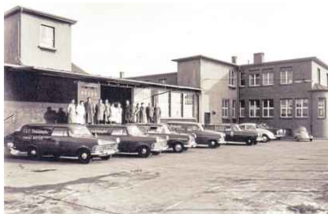
So sah das Firmengebäude an der Eckendorfer Straße und der stattliche Fuhrpark kurz nach Kriegsende aus. Foto: privat
